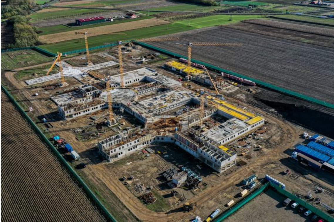
13. ábra: Az épülő börtön Csengeren
